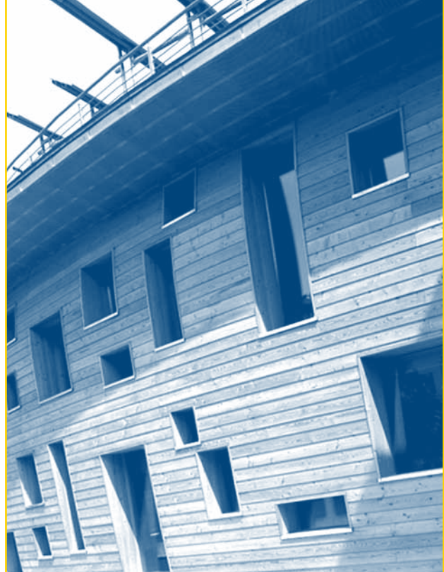
Sede centrale Banca Popolare Etica a Padova
